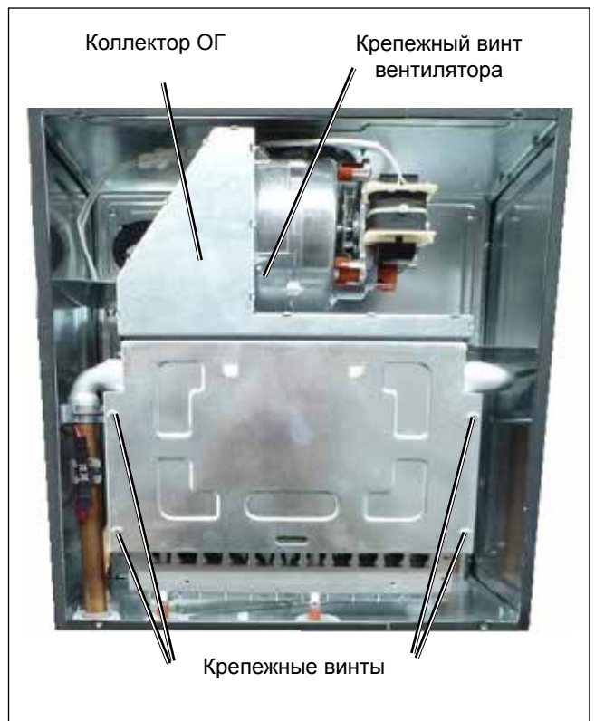
Рис. Корпус камеры сгорания
