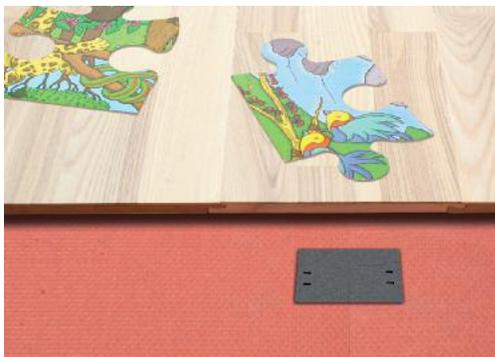
модуля, не содержащую нагревательный кабель, до нужного размера. Затем модули плотно сдвигаются, соединяются плоские электрические разъёмы, и получается единый нагреватель на требуемой площади. Оставшуюся, не обогреваемую площадь, необходимо застелить матами-заполнителями - модулями без нагревательного кабеля. Далее необходимо подсоединить специальный
